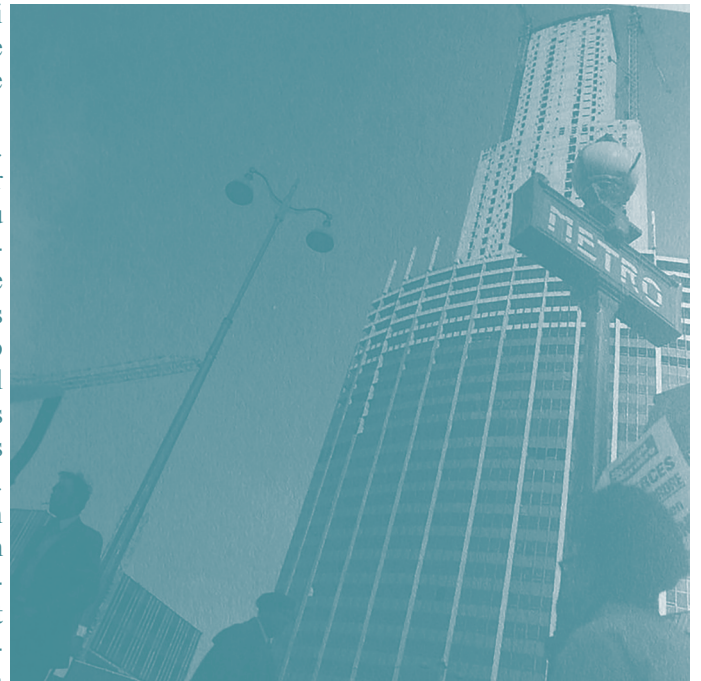
VUE DE LA CONSTRUCTION DE LA TOUR MONTPARNASSE, DATE ET PHOTOGRAPHE INCONNU·E·S. DROITS RÉSERVÉS. VIEW OF THE MONTPARNASSE TOWER CONSTRUCTION, DATE AND PHOTOGRAPHER UNKNOWN. ALL RIGHTS RESERVED.
