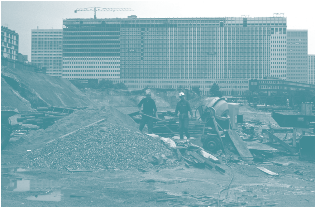
PIERRE JAMET, CHANTIER DE LA TOUR EN PRÉPARATION DEVANT LA GARE MONTPARNASSE, VERS 1970. © PIERRE JAMET PIERRE JAMET, TOWER SITE IN PREPARATION IN FRONT OF MONTPARNASSE TRAIN STATION, CIRCA 1970. © PIERRE JAMET
